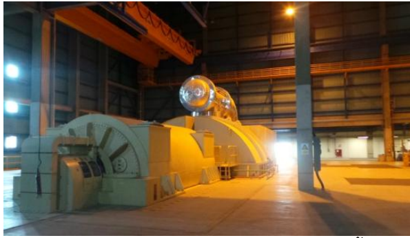
รูปที่ ค-4 การครอบเครื่องจักรด้วยวัสดุดูดซับเสียงและติดตั้งชุดลดเสียง (Silencer)
