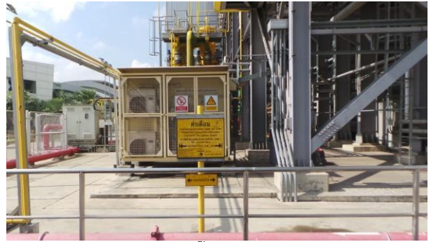
รูปที่ ค-15 การติดตั้งป้ายบอกตำแหน่งและทิศทางของท่อส่งก๊าซ
