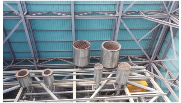
รูปที่ ค-4 การครอบเครื่องจักรด้วยวัสดุดูดซับเสียงและติดตั้งชุดลดเสียง (Silencer)
